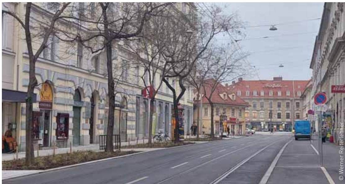
Fertiggestellte Radetzkystraße mit Neuaufteilung des Straßenraums.
