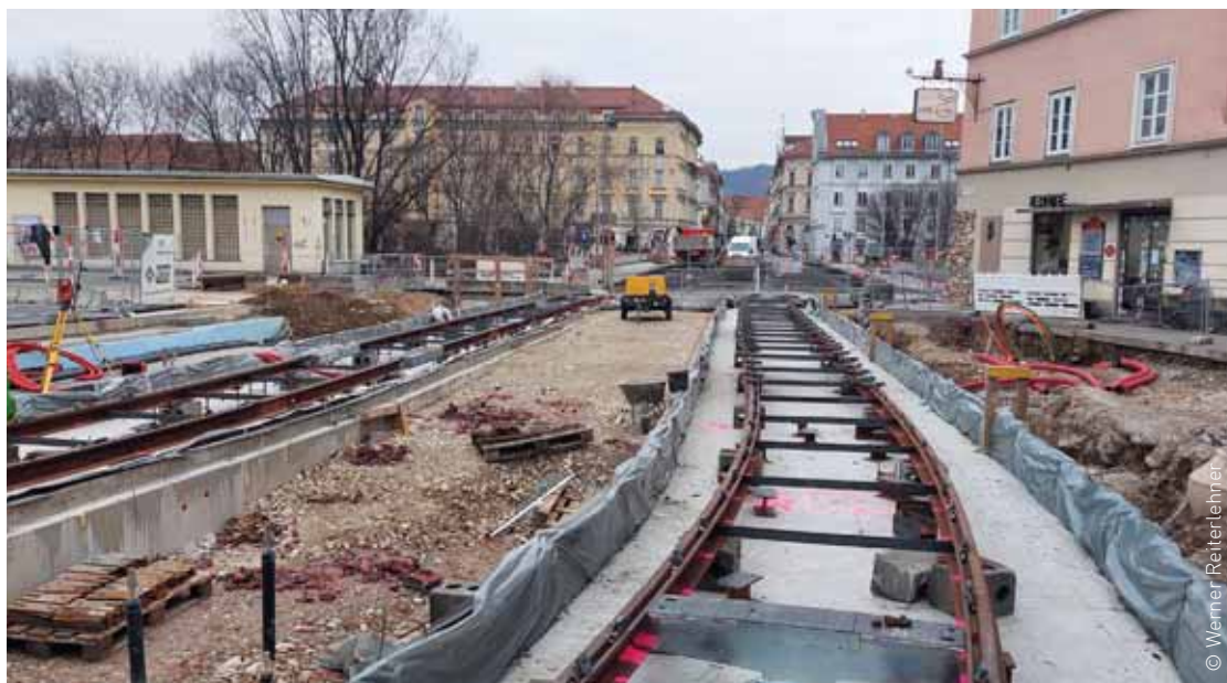
Andreas-Hofer-Platz in der Bauphase im Jänner 2024 mit Blick zur Tegetthoffbrücke.
