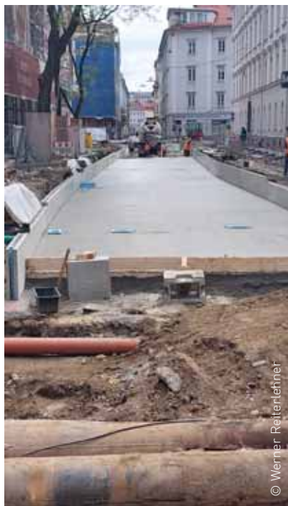
Neutorgasse in der Bauphase im Mai 2023.
