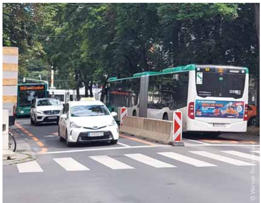
Verkehrssituation auf dem Joanneumring während der Bauphase.
